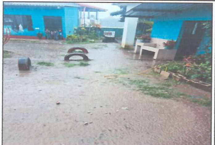
Foto 2: SE PUEDE MEJORAR EL PATIO , DE SUELO A TORTA DE CEMENTO
